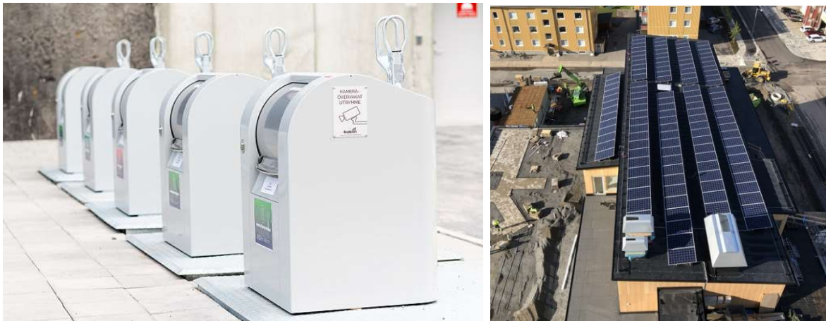
Exempelbilder på kameraövervakad källsortering och solceller på Galärens fastigheter.
