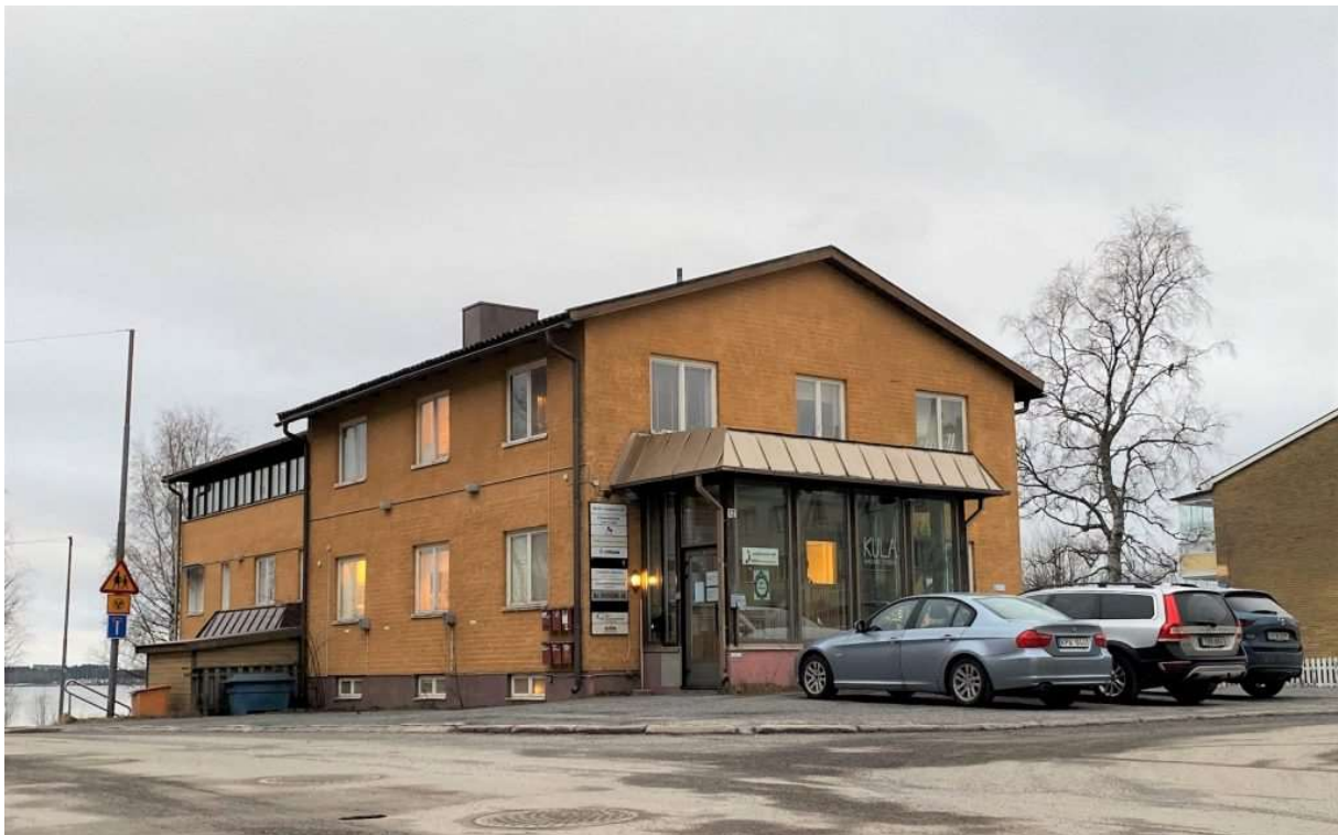
Bild på den befintliga byggnaden på fastigheten Fjärilen 3 på Hornsgatan 12 i Luleå, sett från Residensgatan.
